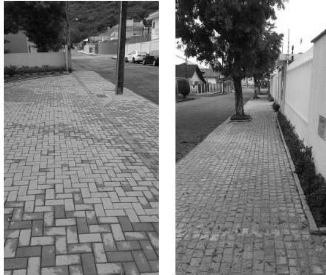
Figura 3 – Calçadas com bloco intertravado (esq.) e pedra miracema (dir.).
